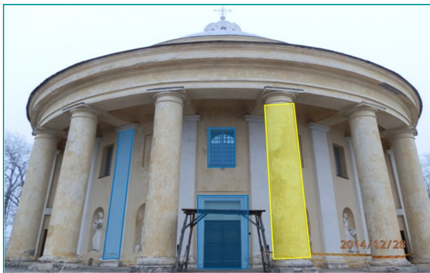
Klasicizmas: Sudervės bažnyčia
