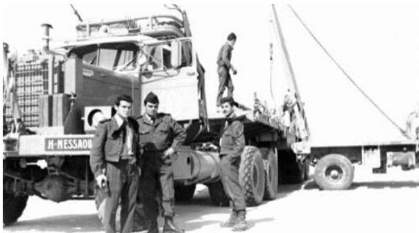
Engins de levage sur la route de Hassi-Messaoud (Sud-Est Algérien) en 1961
